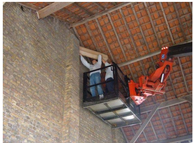
Montage met hoogtewerker gemeente De Panne
